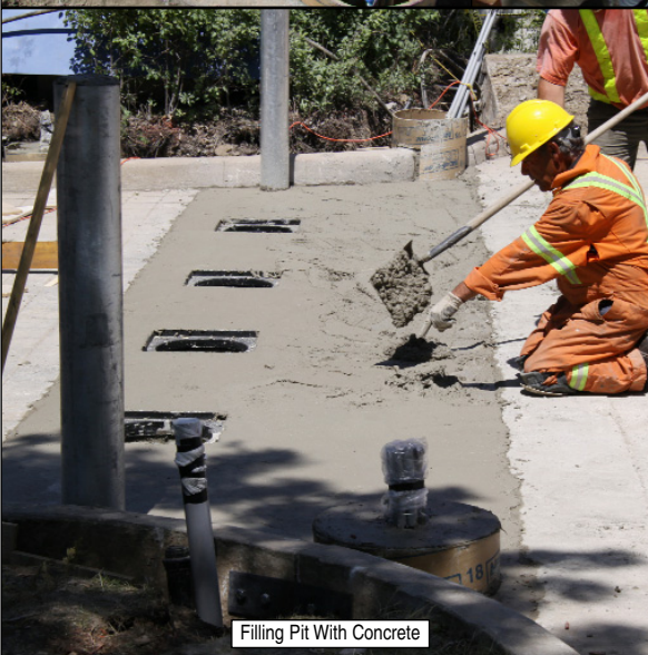
PVC Conduit Installation
